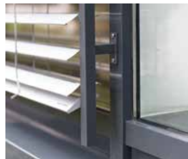
Führungsschiene mit Abstandhalter
